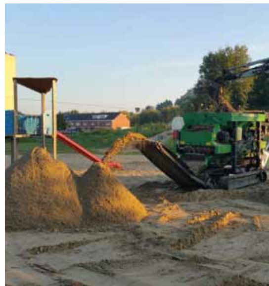
De zandzeefmachine aan het werk.
